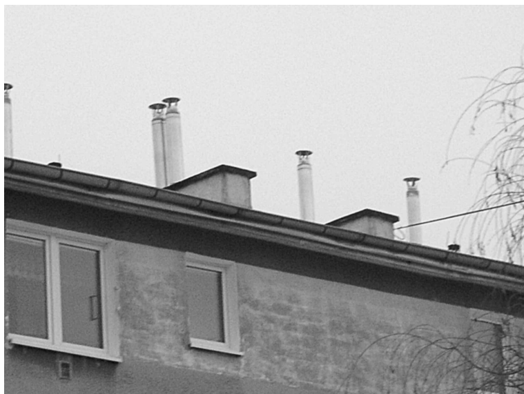
Rys. 1. Dwa w jednym: prosty sposób na zwiększenie ciągu i zagrożenia piorunowego (budynki przy końcu ulicy Partyzantów w Gdańsku-Wrzeszczu).
