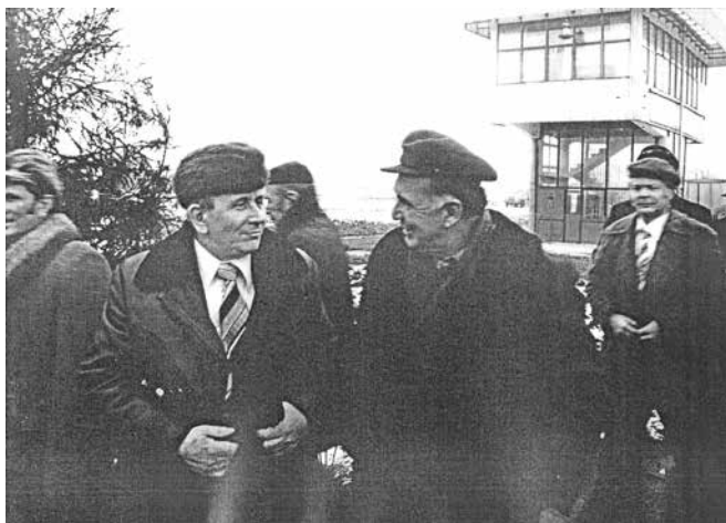
Wizyta na budowie (drugi z lewej – dyr. T. Kolcz)
