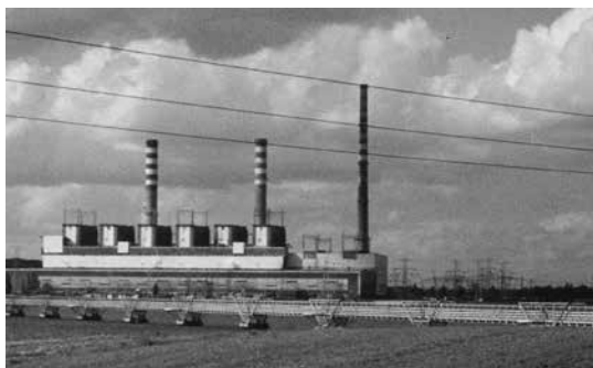
Elektrownia Pątnów (6 × 200 MW na węglu brunatnym + 2 × 200 MW na mazut)
