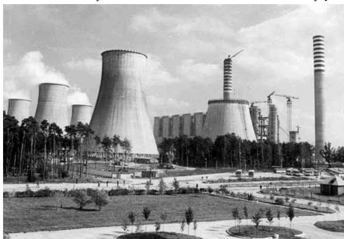
1986 r. – Elektrownia Bełchatów (czynne 8 \times 360 MW, 4 \times 360 MW w budowie)
