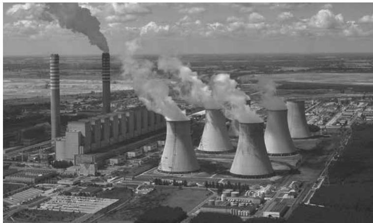
1988 r. – Elektrownia Bełchatów ( 12 \times 360 \text{ MW} = 4320 \text{ MW} )
