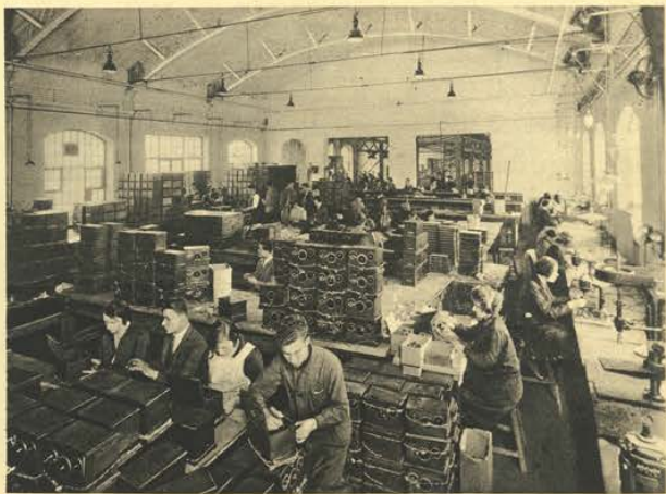
Fragment fabrykacji odbiorników radiowych we fabryce w Warszawie.
