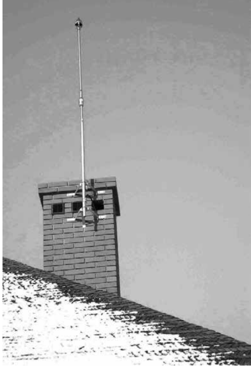
Rys. 6. Przykład bezmyślnej instalacji skopiowany z jednej z polskich stron internetowych
